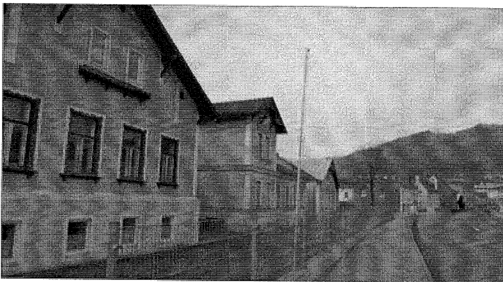
Grazer Straße mit Planungsgebiet (Altbauten links), Foto in Richtung Norden
